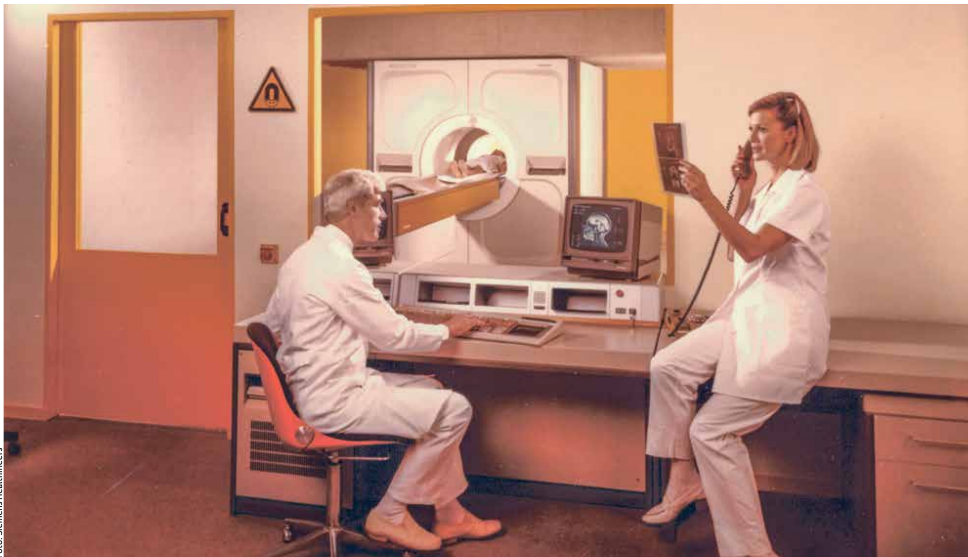
Das MAGNETOM GBS 1 aus dem Jahre 1983 ist der erste kommerzielle Magnetresonanztomograph in der Geschichte von Siemens Healthineers.
